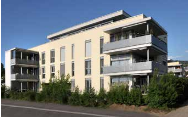
Niederrohrdorf, Mellingerstrasse 11-15 Wohnliegenschaft
