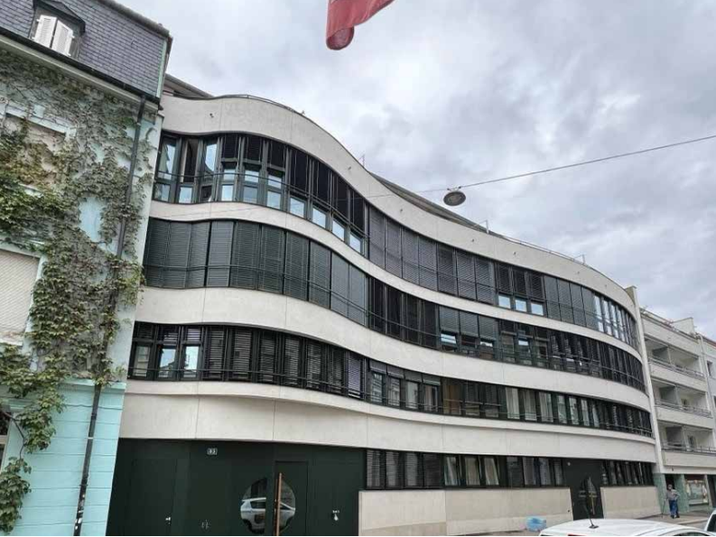
Energetische Sanierung an der Sperrstrasse in Basel
