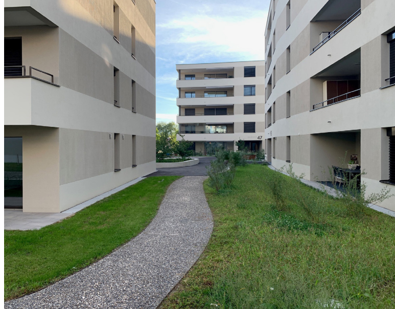
Neubauprojekt «Breitenfeld» in Rothrist (AG)
