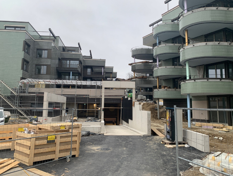
Ersatzneubau an der Alten Landstrasse, Kloten (ZH)
