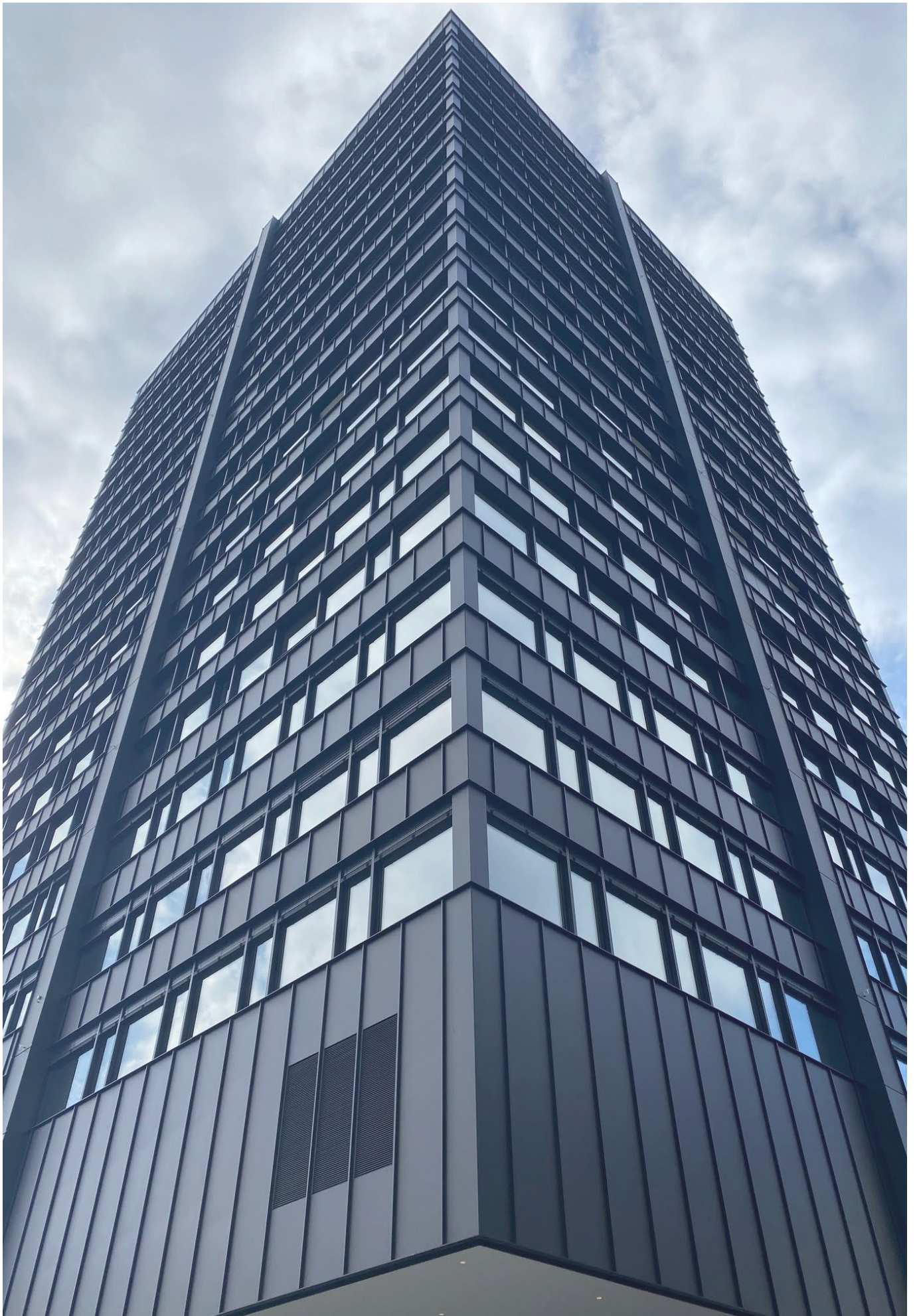
Photo: Akara Tower, Brown Boveri Platz 4, 5400 Baden
