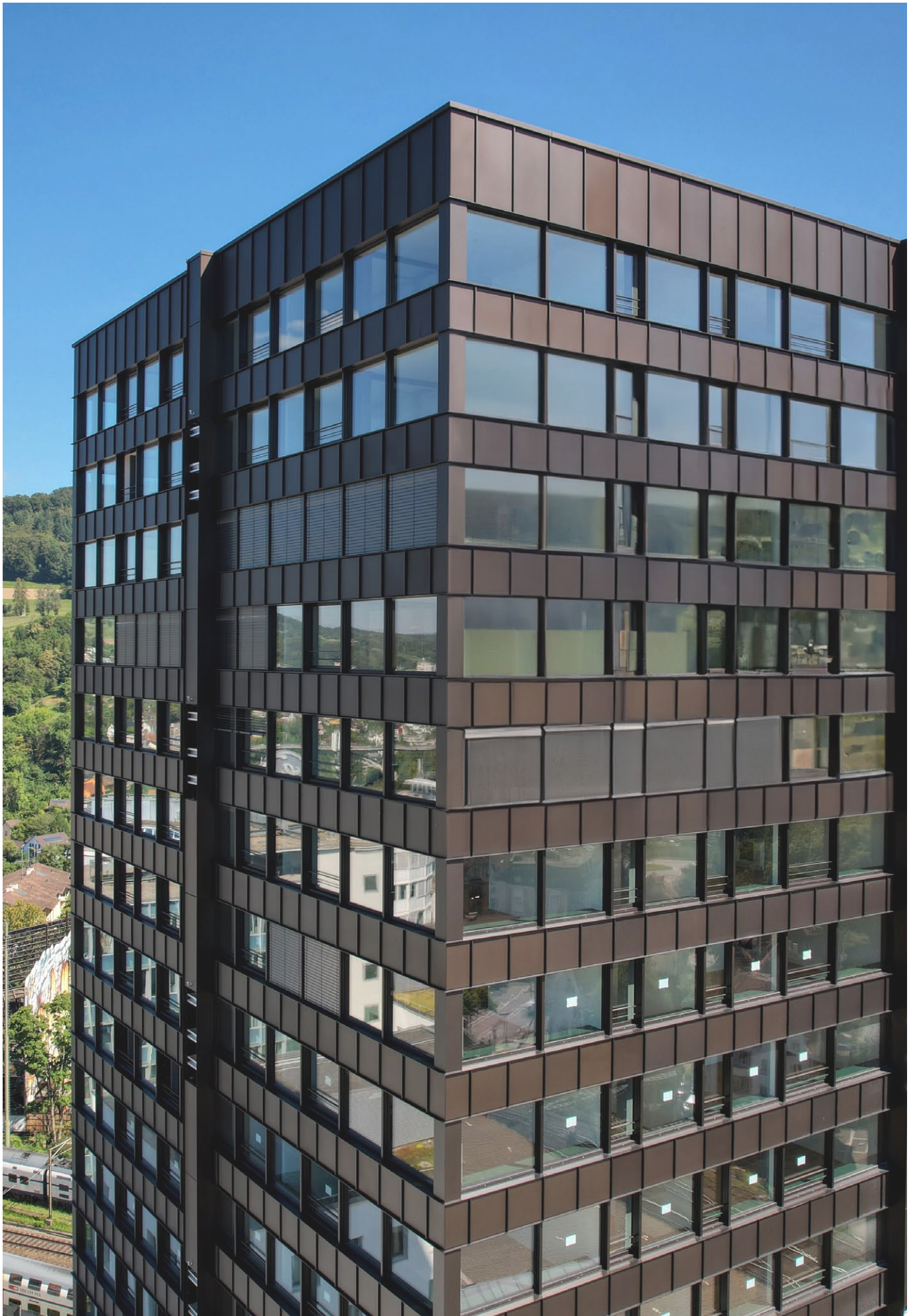
Photo: Akara Tower, Brown Boveri Platz 4, 5400 Baden
