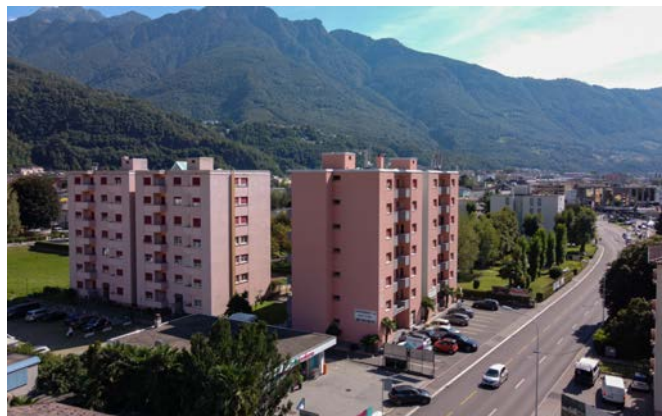
Bellinzona, Via Franco Zorzi 25/25A Immeuble résidentiel
