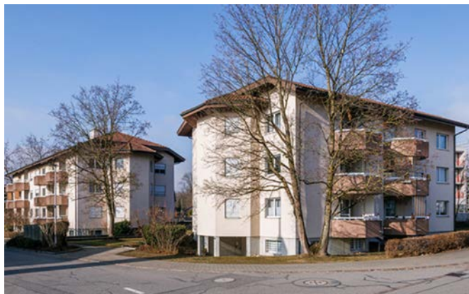
Aarau, Heuweg 3-7 Immeuble résidentiel
