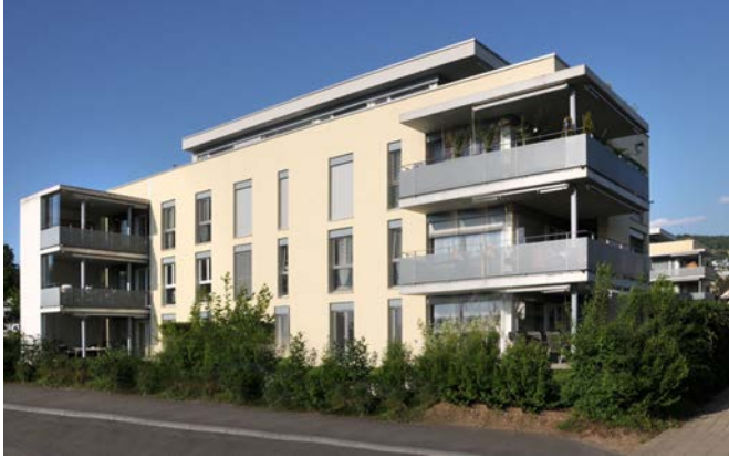
Niederrohrdorf, Mellingerstrasse 11-15 Wohnliegenschaft
