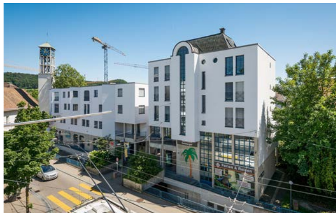
Neuhausen am Rheinfall, Wildenstr. 1-5, Zentralstr. 9 Gemischt genutzte Liegenschaft
