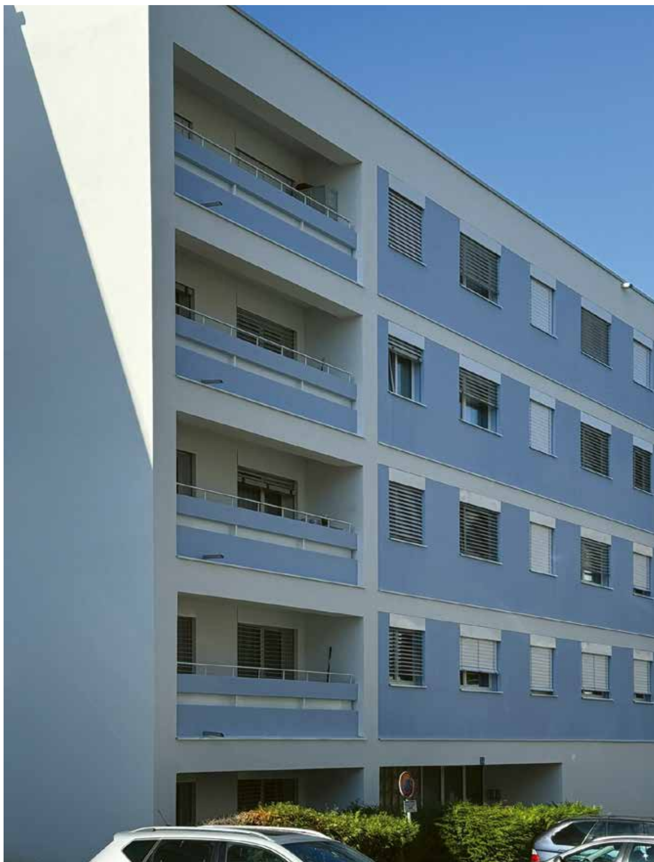
Rue de Caudray 32, 34, 36, Renens (après rénovation totale)
