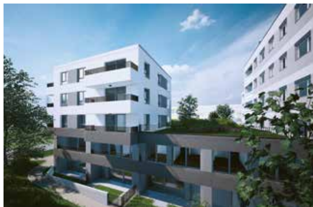
Visualisation du projet d'extension du nouvel immeuble remplaçant les surfaces commerciales à Rue du Caudray 32, Renens
