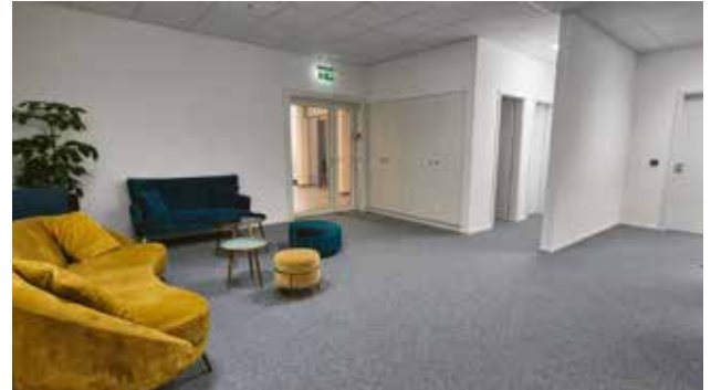
Etoy – Espaces communs du plateau vacant au 2 ème étage qui a fait l'objet de travaux de compartimentage
