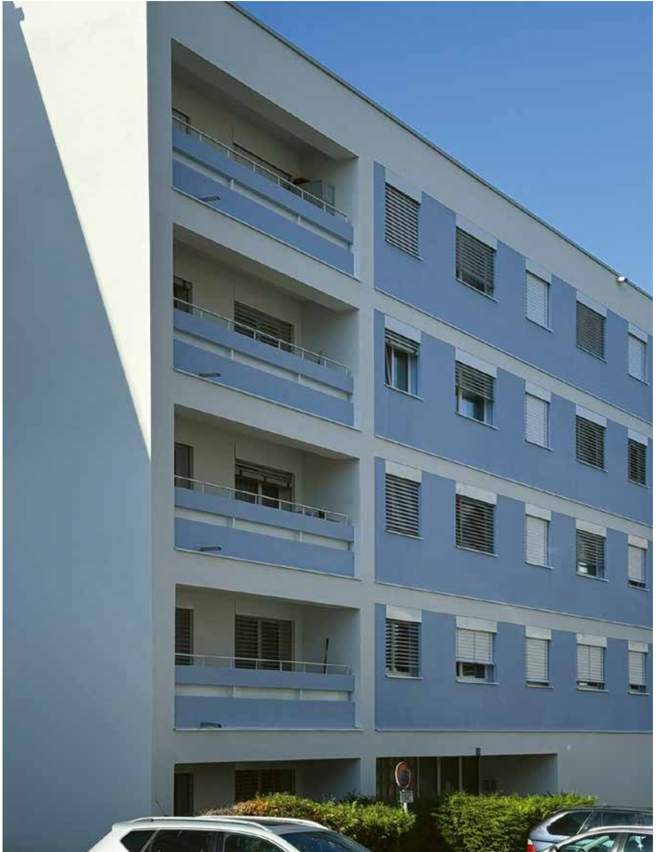
Rue de Caudray 32, 34, 36, Renens (nach vollständiger Renovierung)
