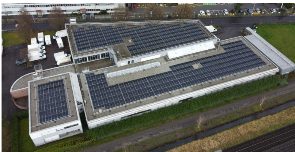
Figure 1 - installation photovoltaïque Chemin des Roses 90 à Villeneuve
