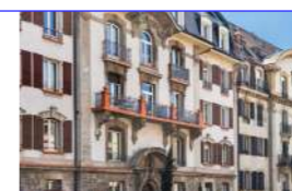
Lausanne (VD) Avenue de Bêthusy 30
