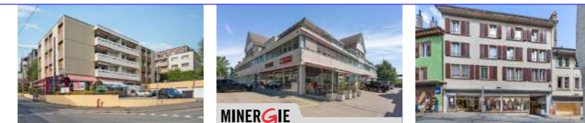
Pully (VD) Chemin des Roches 1
