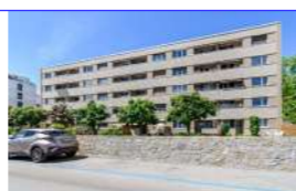
Neuchâtel (NE) Rue de Grise-Pierre 26, 28
