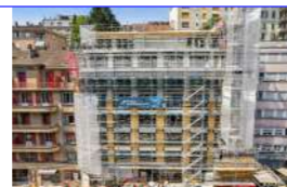
Lausanne (VD) Rue de la Borde 17
