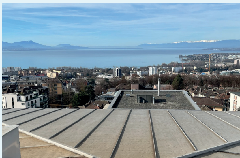
Vue actuelle depuis la future terrasse de la surélévation Aktuelle Aussicht von der zukünftigen Dachterrasse der Aufstockung.
