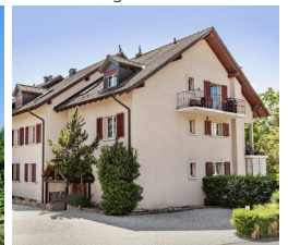
COMMUGNY (VD) Route de l'Eglise 7a, 7b
