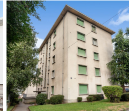
LAUSANNE (VD) Avenue des Bergières 59
