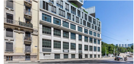
Geneva, Rue des Deux-Ponts 2-4
