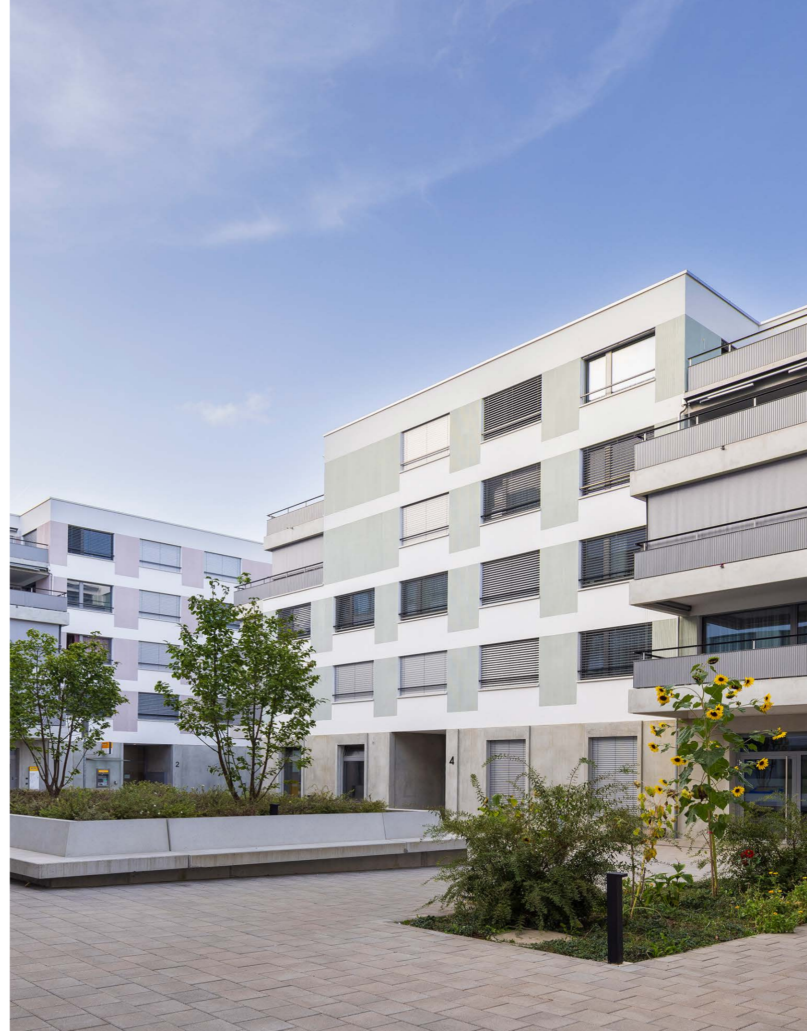
Biberist, Zentrumweg 2, 2a, 4, 6, 8, 10
