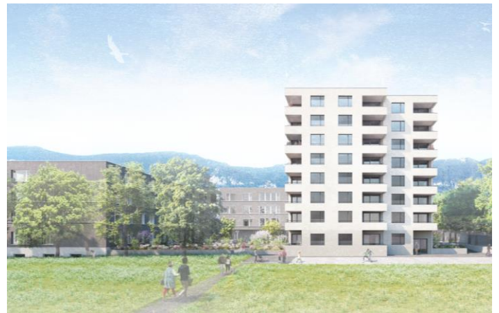
Bellach SO, Grederstrasse 66 (im Bau)
