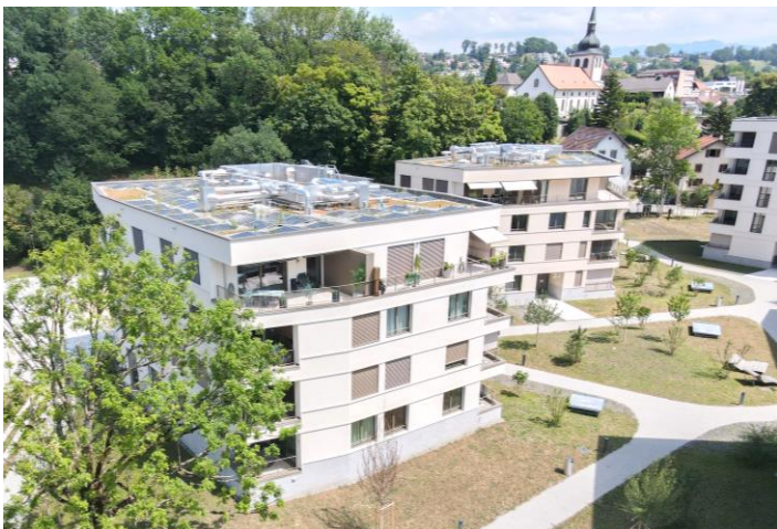
Marly FR, Les Moulins (55 Neubauwohnungen)
