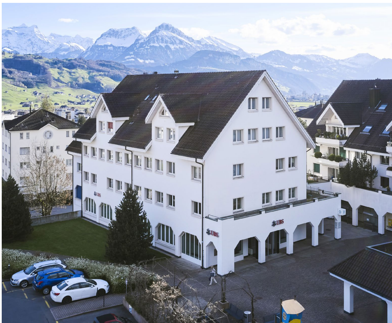
Photo: Oberer Steisteg 18/20, 6430 Schwyz
