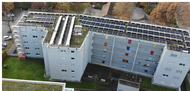
Un nouvelle installations photovoltaïques à Kreuzlingen
