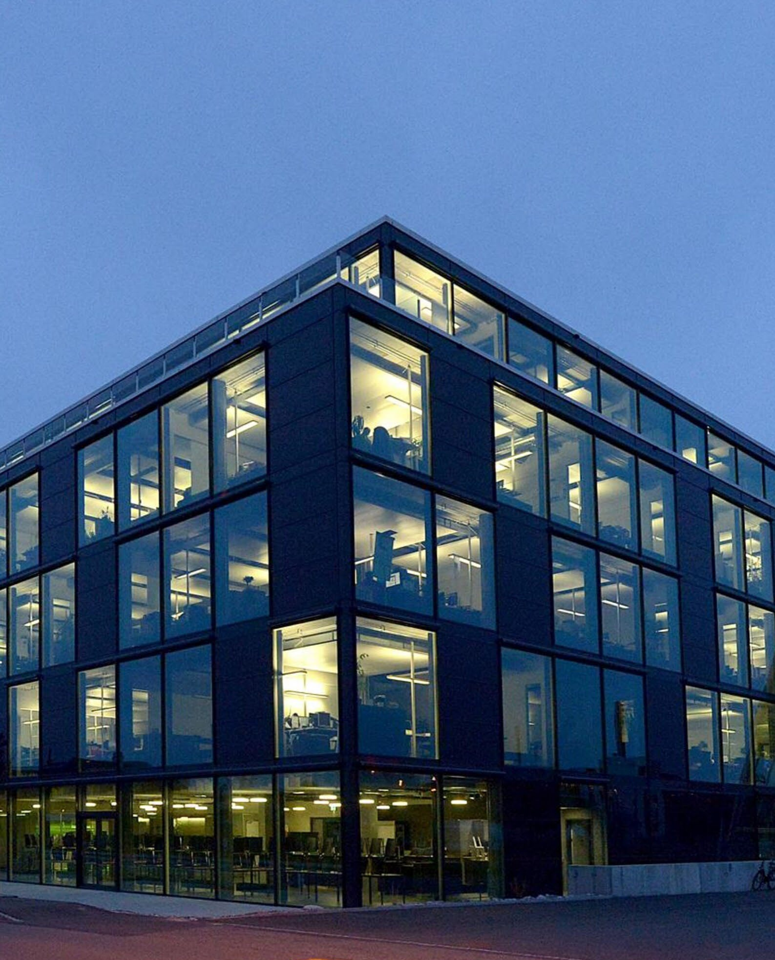
Gwatt-Thun (BE), Schorenstrasse 39
