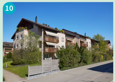
Scherzenbach Blattenstrasse 1–7 / Vierstrasse 2–12
