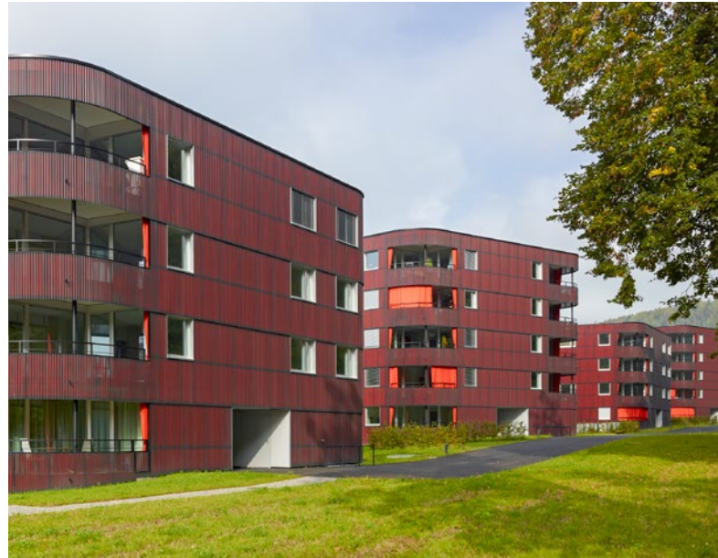
Schaffhausen | Wirbelwies 1–16 / Hauentalerstrasse 150–158
