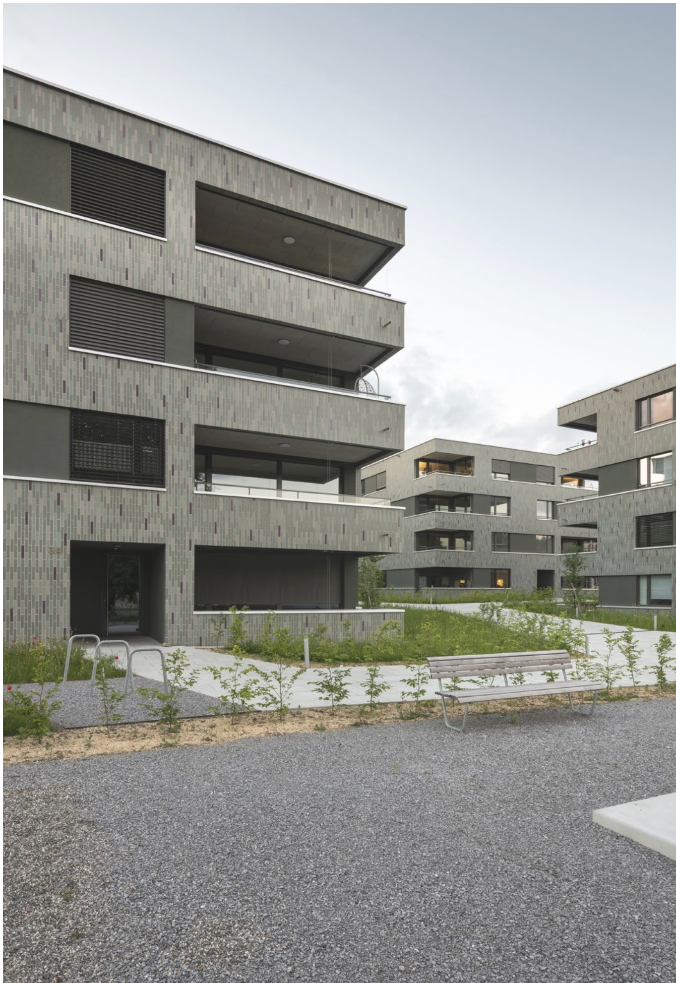
Foto: Überbauung «Quadro», Bahnhofplatz 3a-d, Wangen bei Olten
