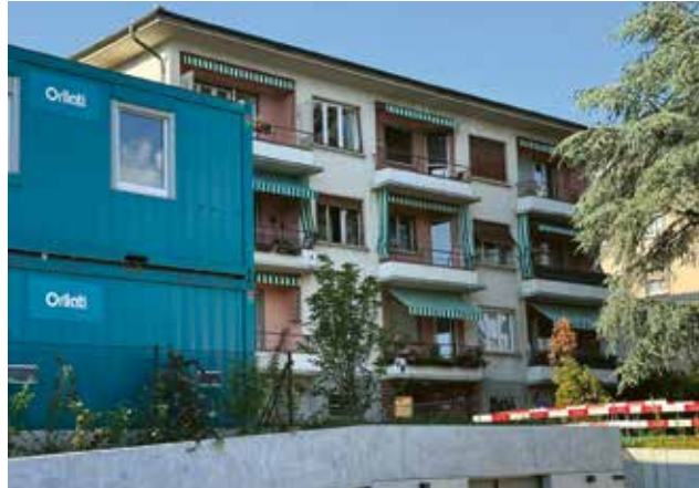
Immeuble situé au Chemin du Ruisselet 22, à Pully, peu avant le début des travaux de rénovation énergétique et de surélévation en mai 2024
