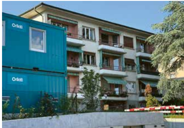
Gebäude am Chemin du Ruisselet 22 in Pully, kurz vor Beginn der energetischen Sanierungs- und Aufstockungsarbeiten im Mai 2024.
