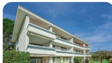
Corseaux Chemin des Cornalles 21/25
