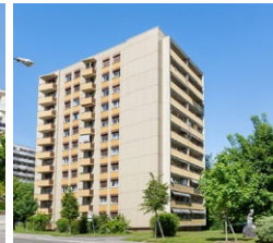
CHAVANNES-PRÈS-RENNES (VD) Rue de la Blancherie 5
