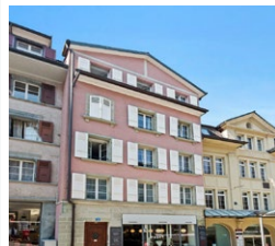
LAUSANNE (VD) Rue de la Mercerie 14, 16, 18, 20
