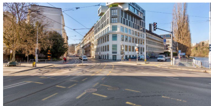
Geneva, Rue des Deux-Ponts 2-4
