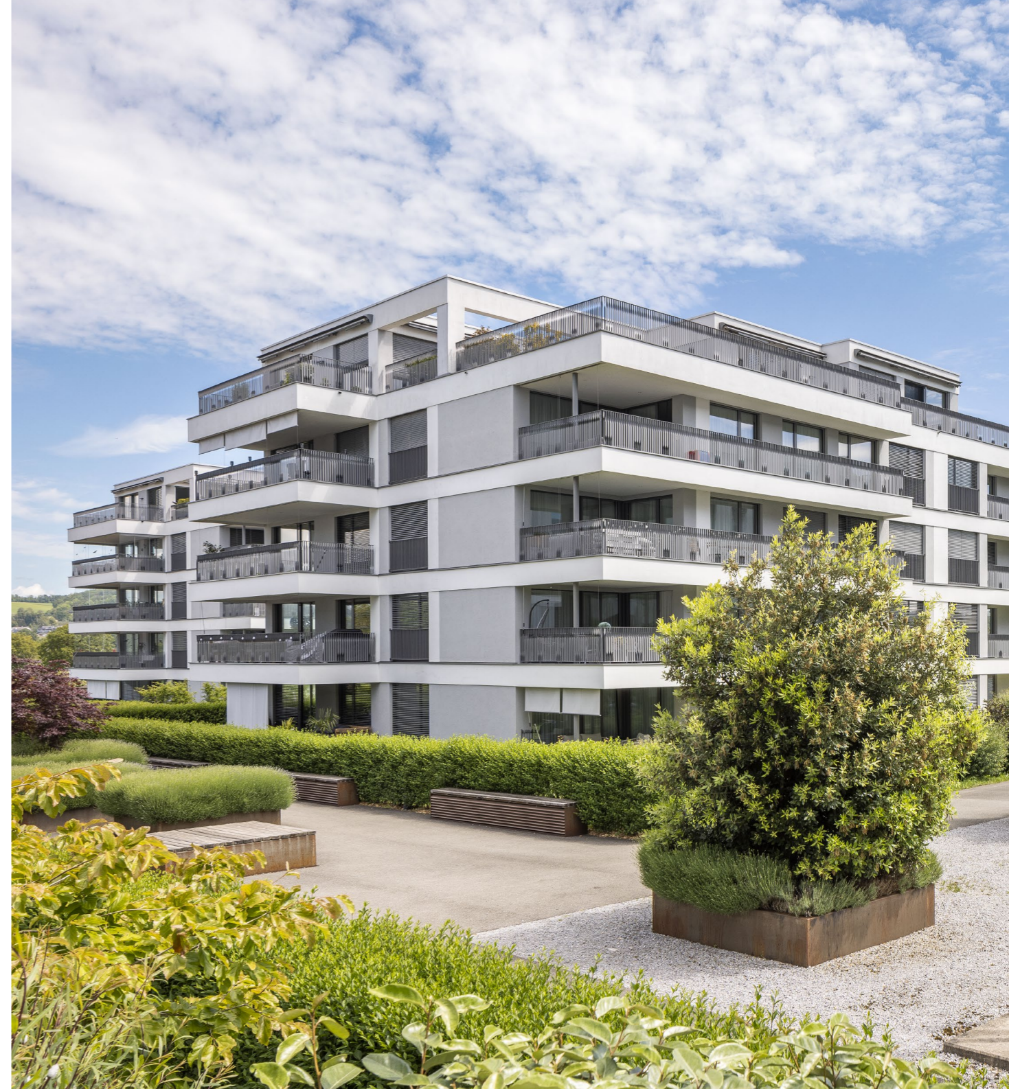
Bad Zurzach, Weissensteinweg 4, 6
