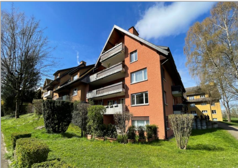
Rénovation d'un immeuble d'habitation Schwandenholzstrasse, Zurich
