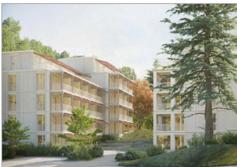
Démolition-reconstruction d'un immeuble d'habitation Stettbacherrain, Zurich Volume d'investissement d'env. 30 de mio. CHF Entrée en possession au 2 ème trimestre 2025
