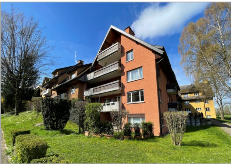
Gesamtsanierung Wohnliegenschaft Schwandenholzstrasse, Zürich Anlagevolumen ca. CHF 7 Mio. Baubeginn 2. Quartal 2026
