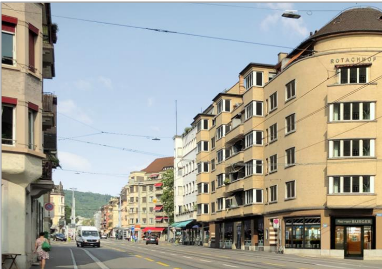
Gesamtsanierung Gemischte Liegenschaft Birmensdorferstrasse, Zürich Anlagevolumen ca. CHF 8 Mio. Baubeginn 4. Quartal 2024
