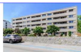
Neuchâtel (NE) Rue de Grise-Pierre 26, 28
