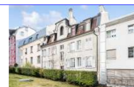
Lausanne (VD) Avenue de France 20
