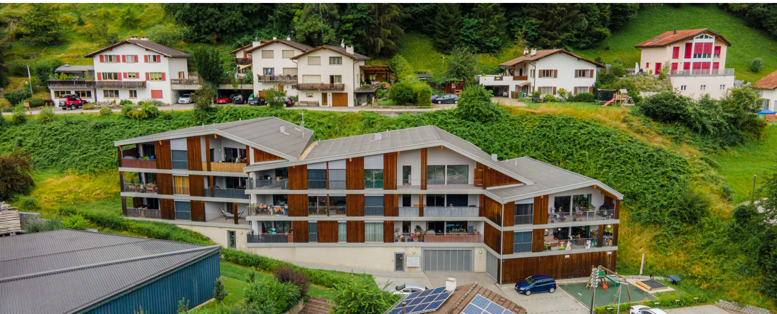
Wohngebäude AKISV in Summaprada GR
