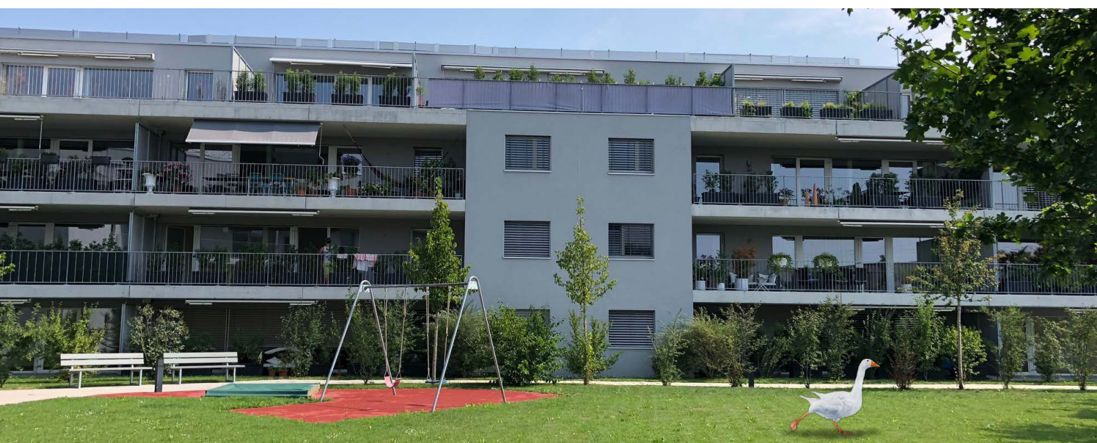
Wohngebäude AKISV in Herrenschwanden BE
