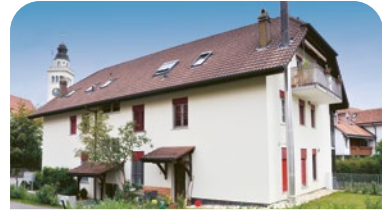
Aeschi SO Schulhausstrasse 2/6
