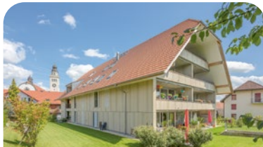
Aeschi SO Schulhausstrasse 4
